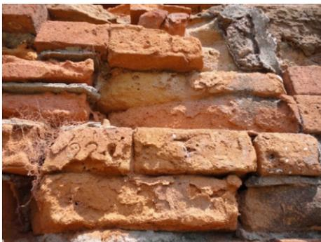
**Metode perbaikan** : Dengan mengganti material dan sistem injeksi, yaitu menambal batuan dengan campuran pasir dan semen.
