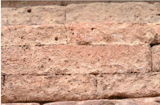
**Metode perbaikan** : Dengan mengganti material dan sistem injeksi, yaitu menambal batuan dengan campuran pasir dan semen.
