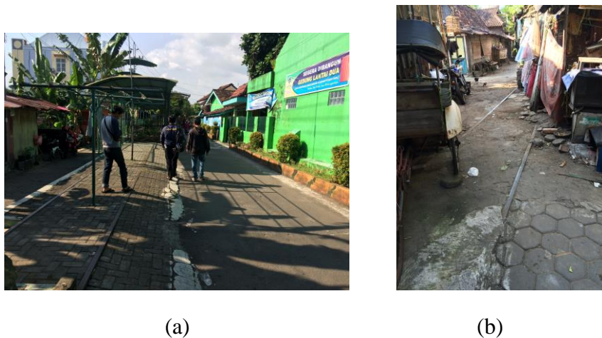
Gambar 5.4 Kondisi Jalur Eksisting Kereta Api Bagian 2
