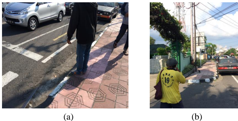
Gambar 5.3 Kondisi Jalur Eksisting Kereta Api Bagian 1
