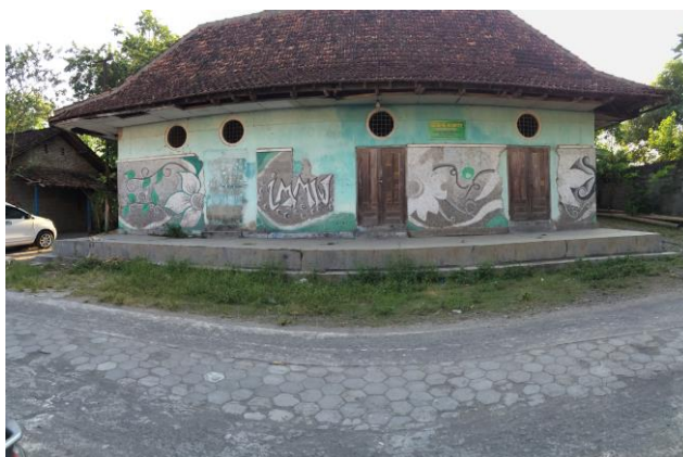
Gambar 5.10 Kondisi Jalur Eksisting Kereta Api Bagian 8
