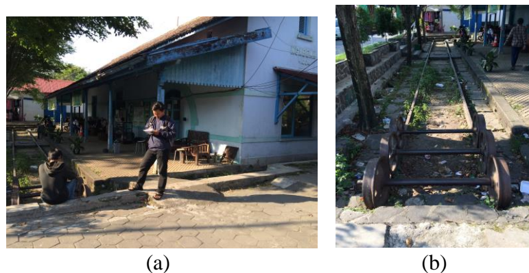
Gambar 5.6 Kondisi Jalur Eksisting Kereta Api Bagian 4
