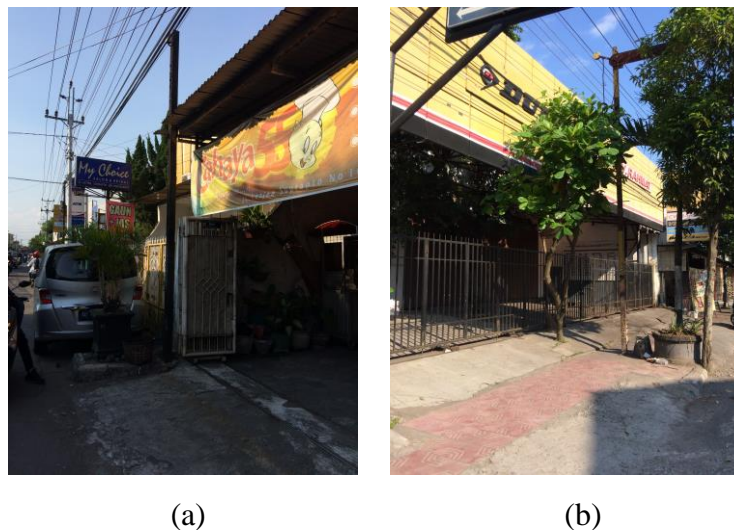
Gambar 5.5 Kondisi Jalur Eksisting Kereta Api Bagian 3
