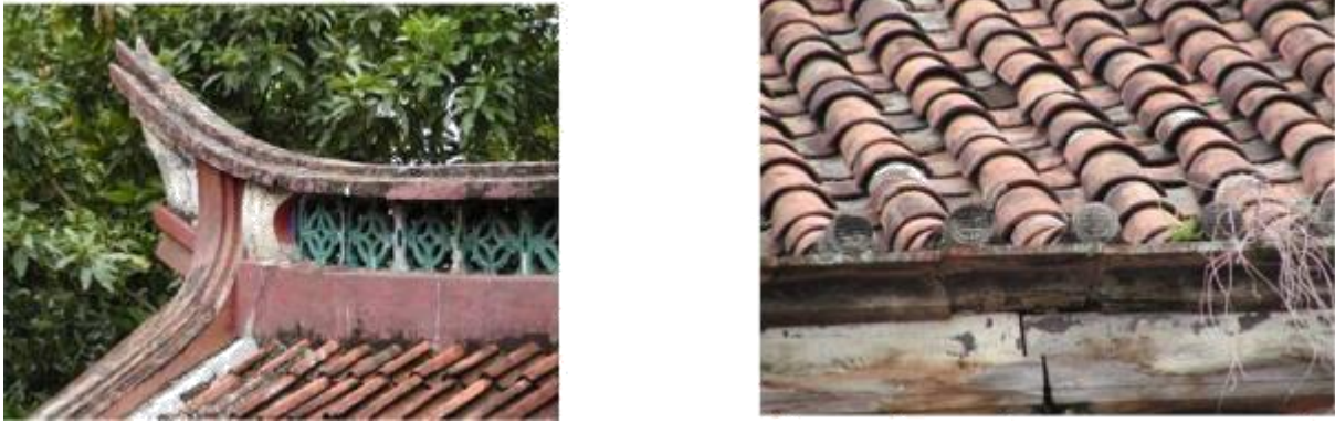
Gambar 40. Ujung atap yang melengkung pada sebuah rumah di Pecinan dan bentuk genting yang khas
