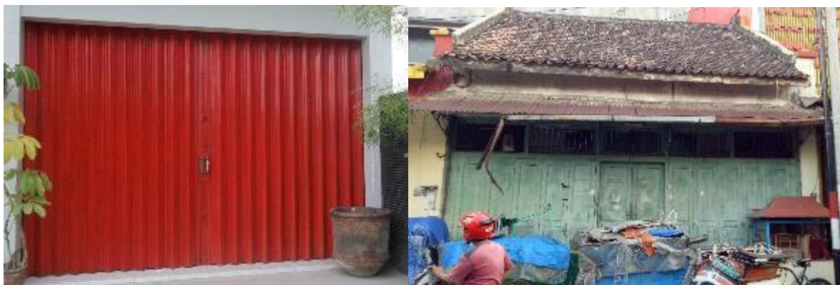
Gambar 44. Pintu Rolling door dan pintu lipat
