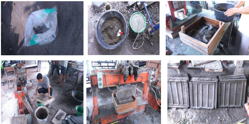
Gambar 2 Pembuatan Genteng Beton. Genteng beton menggunakan bahan tambah abu insinerator. Bahan ditimbang dulu sebelum ditambahkan air, pasir, dan semen. Setelah itu dimasukkan dalam cetakan genteng dan dipress menggunakan alat press. Benda tercetak dirawat hingga 28 hari.
