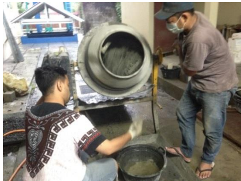
Gambar L.49.3. Proses pengadukan campuran material menggunakan mesin pengaduk/ mixer
