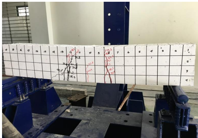
7.Pola Keretakan BP-1 Tanpa Perkuatan (B)
