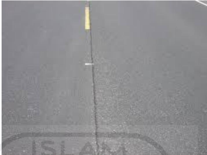
**Gambar 3.5.** Retak Sambungan Jalan
