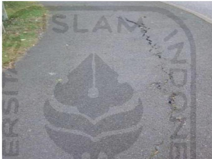
**Gambar 3.4.** Retak Sambungan Bahu dan Perkerasan
