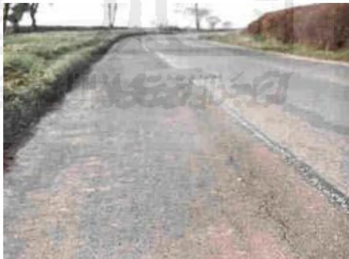
**Gambar 3.6.** Retak Sambungan Pelebaran Jalan
