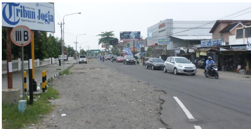
Gambar 5.1. Kondisi Simpang di Ruas Jalan Yogyakarta – Barongan (Imogiri) (Sumber: Data Primer)
