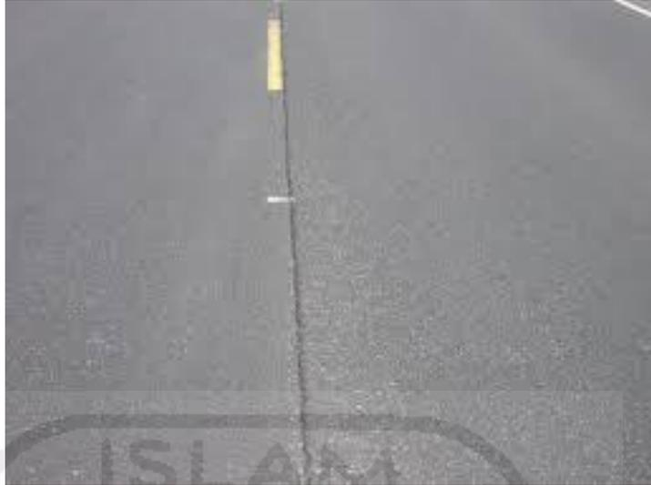
**Gambar 3.5.** Retak Sambungan Jalan
