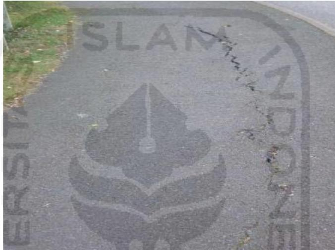
**Gambar 3.4.** Retak Sambungan Bahu dan Perkerasan
