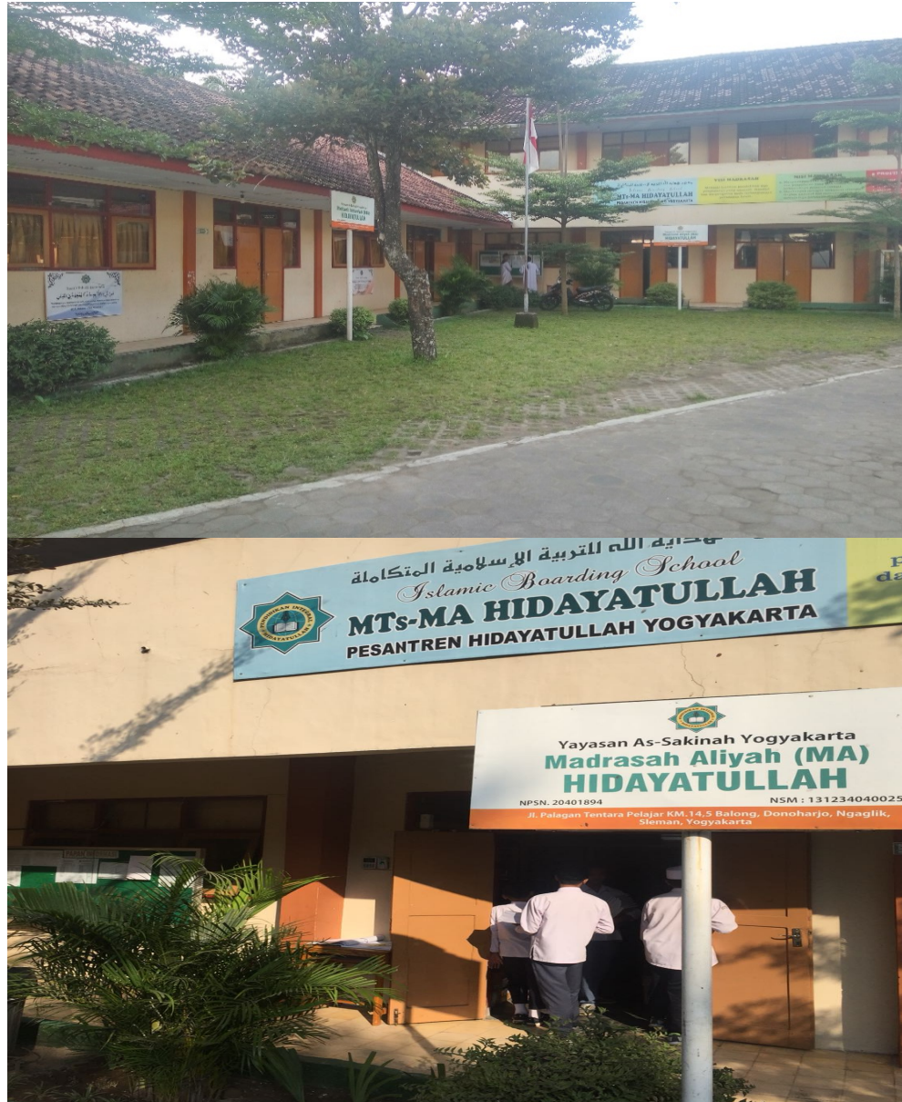
Sumber : Dokumentasi Penulis
