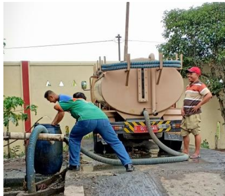
Gambar 4.8 Proses Penggelontoran Lumpur Tinja dari Tangki Truk ke IPLT Sewon. Sumber: Dokumentasi 15 Mei 2018
