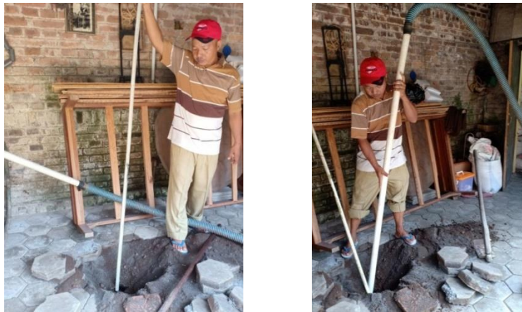
Gambar 4.5 Pengukuran Tinggi Lumpur Tinja dan Proses Penyedotan Lumpur Tinja pada Tangki Septik.
