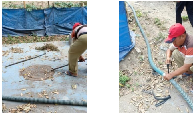
Gambar 4.6 Pembukaan Manhole dan Proses Penambahan Selang Lumpur Tinja pada IPAL komunal.
