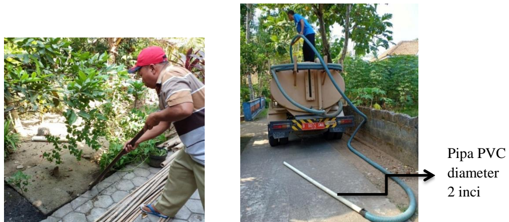
Gambar 4.4 Pencarian Tangki Septik dan Persiapan Selang untuk Penyedotan Lumpur Tinja.
