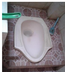
Gambar 4.4 Kloset Jongkok Leher Angsa Sebagai Bangunan Tengah Jamban
