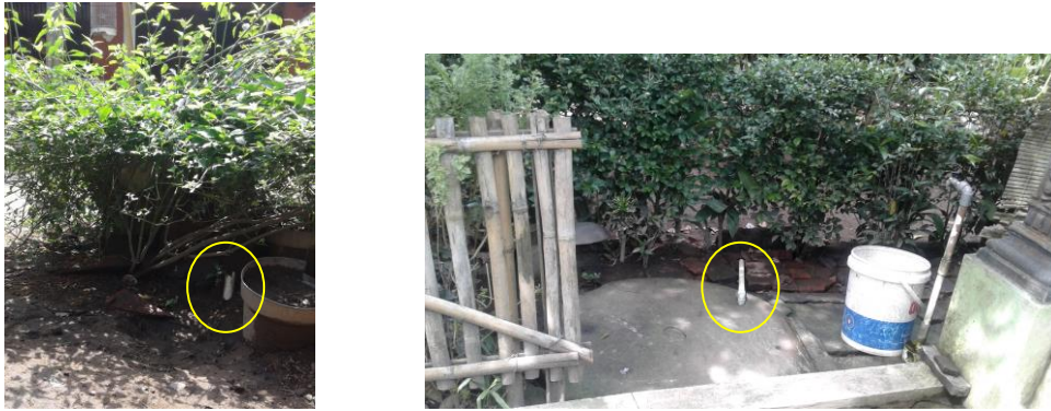
Gambar 4.14 Pipa Udara Tangki Septik Tidak Sesuai SNI
