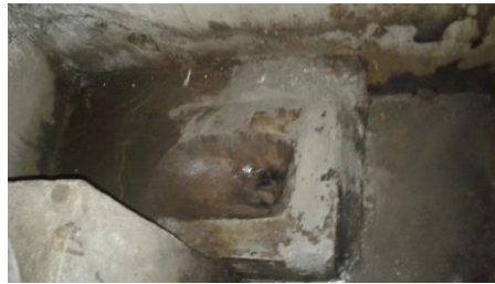
Gambar 4.3 Plengsengan Sebagai Bangunan Tengah Jamban
