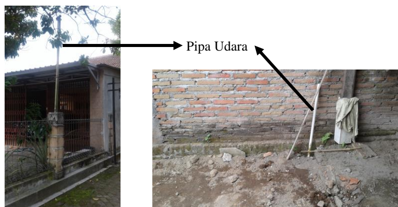
Gambar 4.13 Pipa Udara Tangki Septik Sesuai SNI
