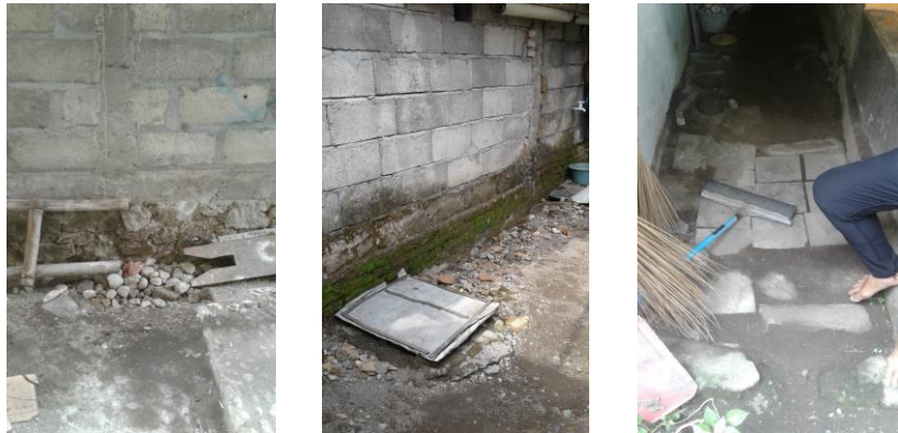
Gambar 4.15 Tangki Septik Tanpa Pipa Udara
