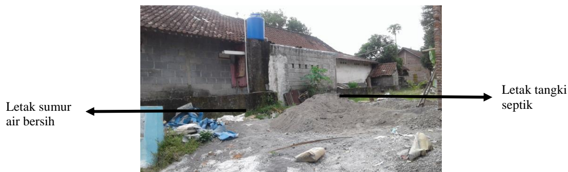
Gambar 4.18 Letak Tangki Septik dan Sumber Air Kurang dari 10 m
