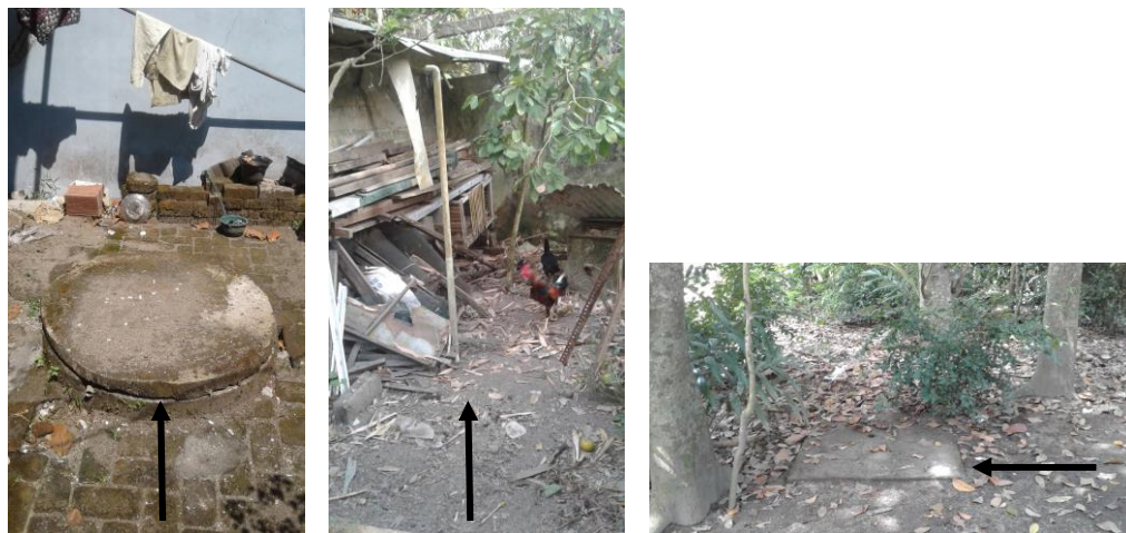
Gambar 4.17 Lokasi Tangki Septik di Luar Bangunan Rumah
