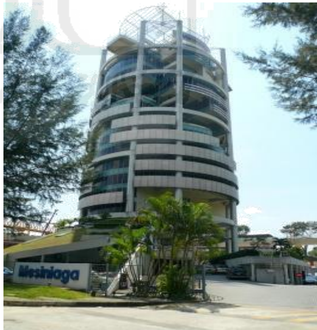
Gambar 2.40 Menara Mesiniaga Malaysia Sumber: Menara Mesiniaga Features Bioclimatics (Malaysia),2010
