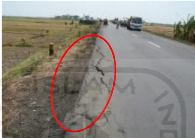
Gambar 3.15 Retak Pinggir (*Edge Crack*)
