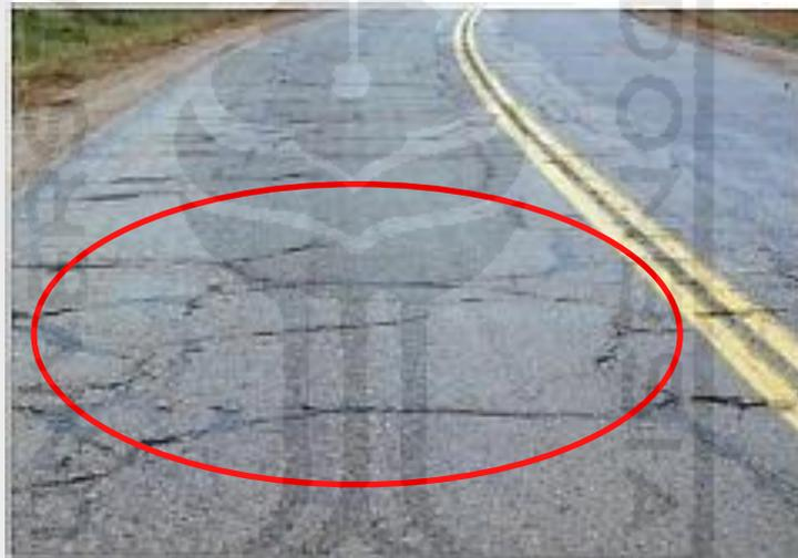
Gambar 3.3 Retak Blok (*Block Cracking*)
