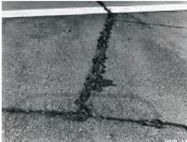
Gambar 3.6 Retak Reflektif Sambungan (*Joint Reflection Cracking*)
