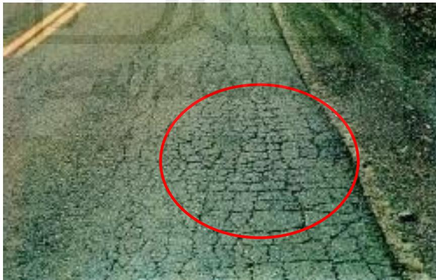
Gambar 3.1 Retak Kulit Buaya (*Alligator Cracking*)
