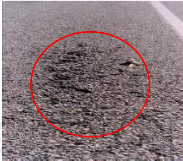
Gambar 3.13 Pelepasan Butiran (*Weathering/Raveling*)
