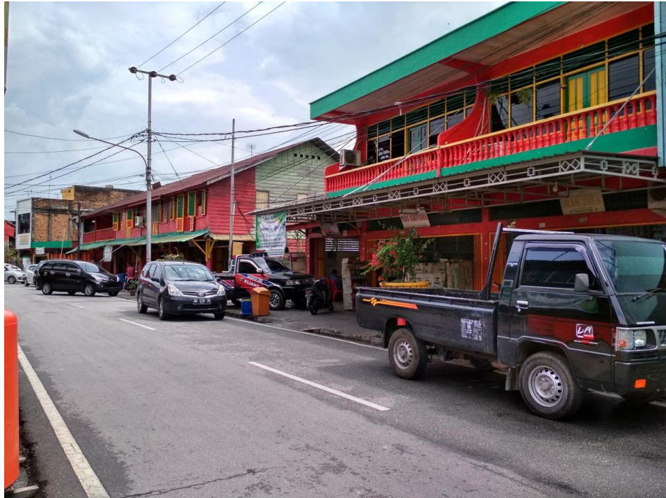
Gambar 2.5 Kondisi Kampung Pecinan
