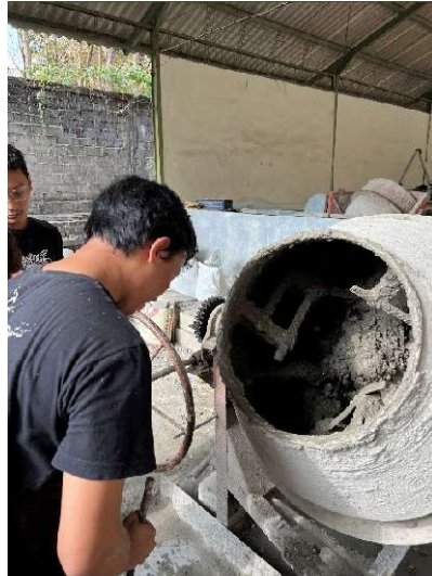
Gambar L. 7.1 Pembuatan Beton Segar
