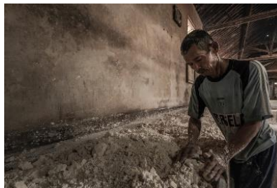
Gambar 4. 3 Pekerja Sedang Melakukan Proses Pemadatan
