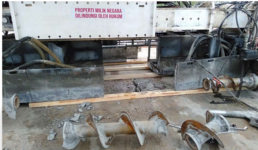
Gambar 76. Pembongkaran Auger Untuk Penyesuaian Perubahan Modul
