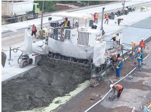
Gambar 29. Penghamparan dengan Slipform Paver
