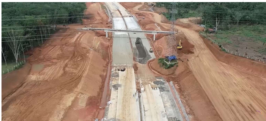
Gambar 47. Lokasi STA 2+700 – 2+800 sisi kanan
