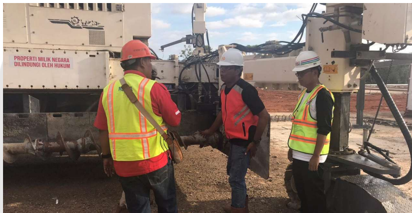
Gambar 48. Inspeksi Alat Paver Sebelum Mulai Pekerjaan
