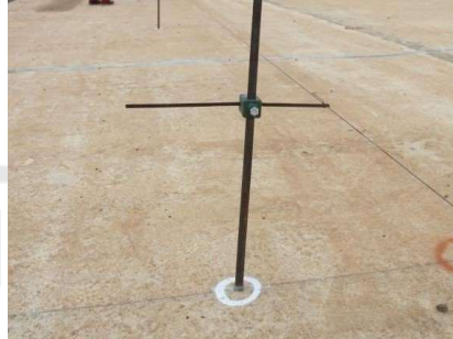
Gambar 23. Pemasangan Kawat String
