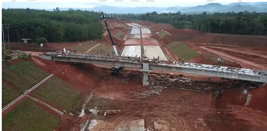
Gambar 65. Pekerjaan Penyiapan Lahan Rigid Pavement Terpotong Overpass
