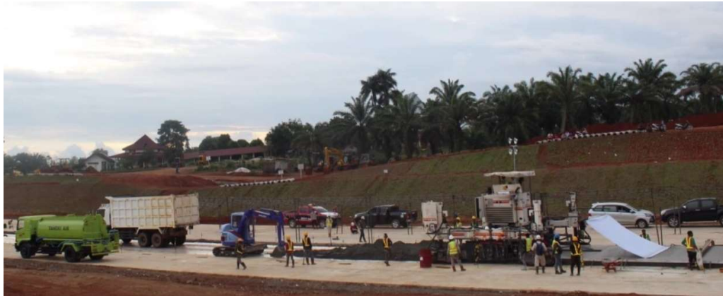
Gambar 51. Pekerjaan Rigid Pavement Perdana di STA 6+160 – 6+410 Lajur R1
