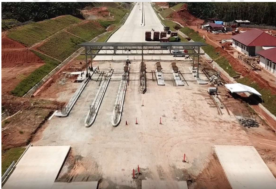
Gambar 42. Gerbang dan Kantor Jalan Tol di STA 0+850
