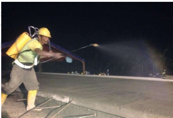
Gambar 33. Penyemprotan Curing Compound
