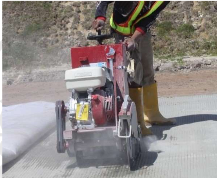
Gambar 34. Cutting Rigid dengan Saw Cutter
