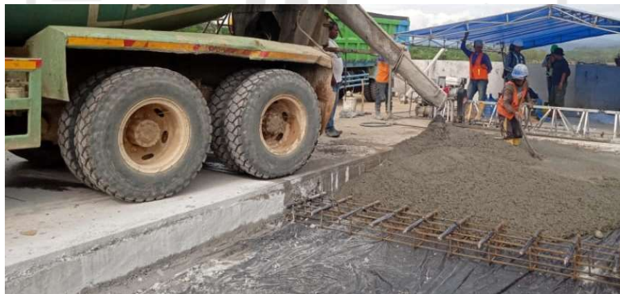
Gambar 66. Pekerjaan Rigid Pavement Metode Manual.
