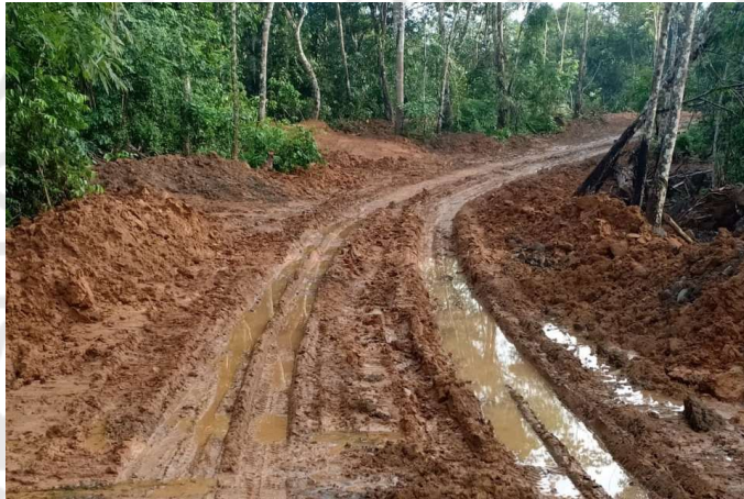
Gambar 71. Kerusakan Jalan Akses Akibat Hujan
