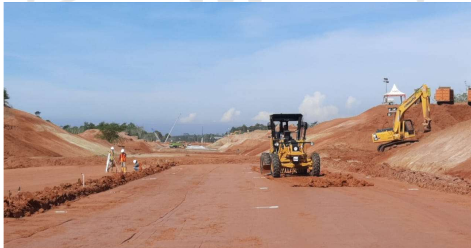
Gambar 72. Perbaikan Top Subgrade
