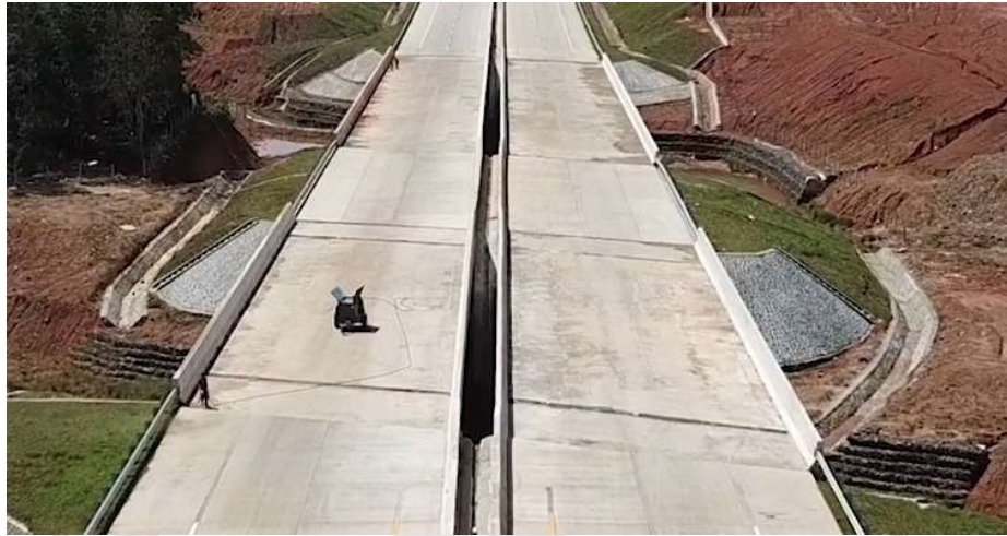
Gambar 43. Jembatan STA 1+575 (bawah) dan STA 1+700 (atas)
