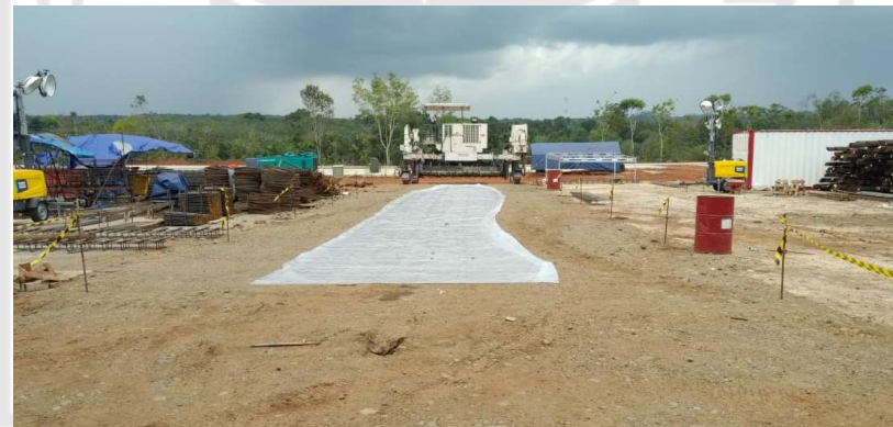
Gambar 49. Lokasi Trial Rigid di Stockyard PT. Utama Karya Infrastruktur
