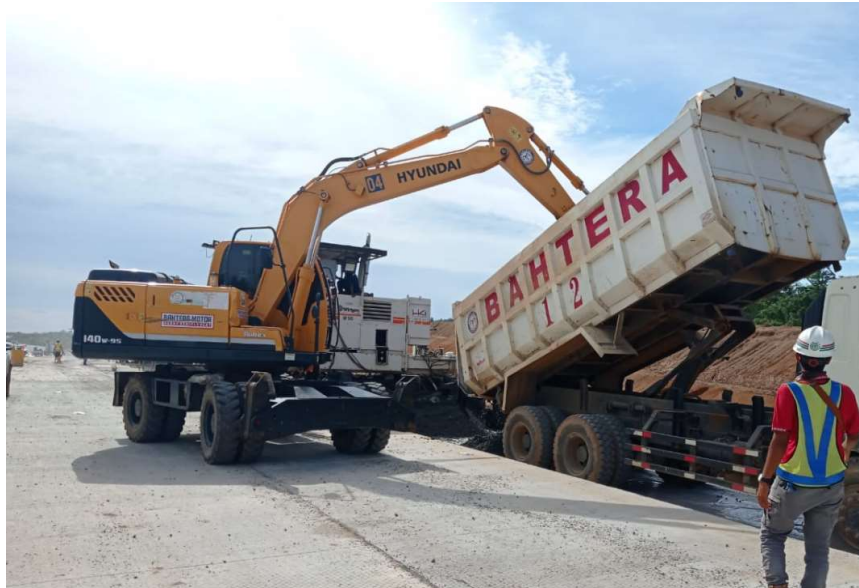
Gambar 57. Pekerjaan Rigid Pavement Modul 3,1 meter
