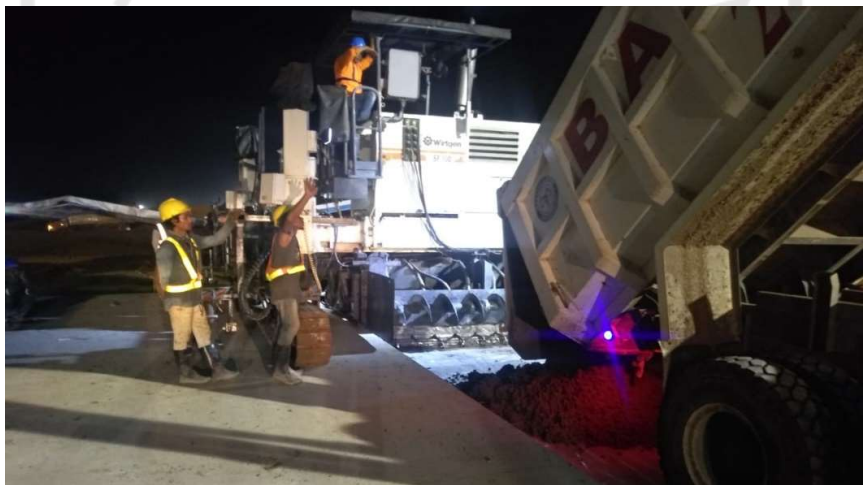
Gambar 83 Pekerjaan Rigid Pavement di Malam Hari
