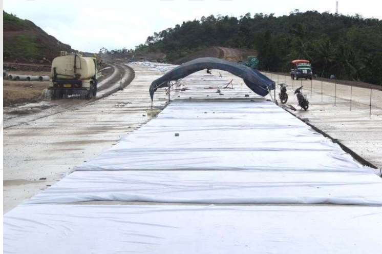
Gambar 35. Rigid Ditutup dengan Geotextile
