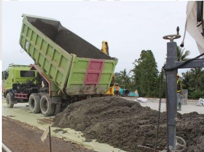
Gambar 27. Loading Beton Kelas P dari Dump Truck
