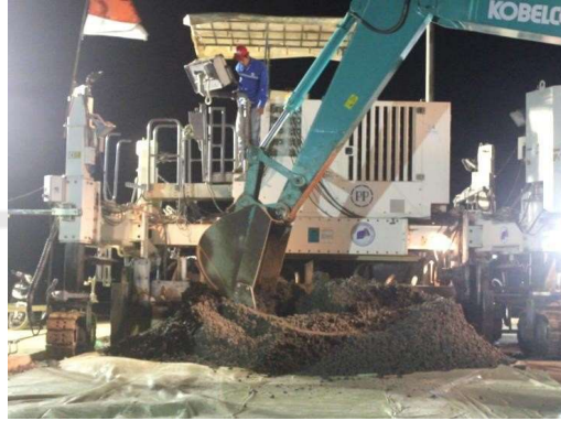
Gambar 28. Perataan Beton dengan Excavator
