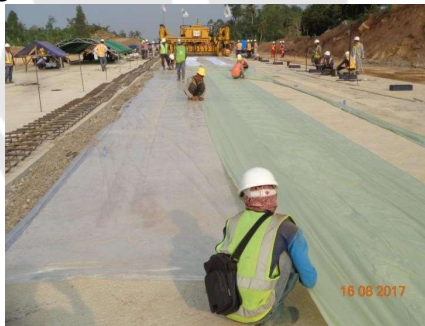
Gambar 24. Pemasangan Plastik Cor
