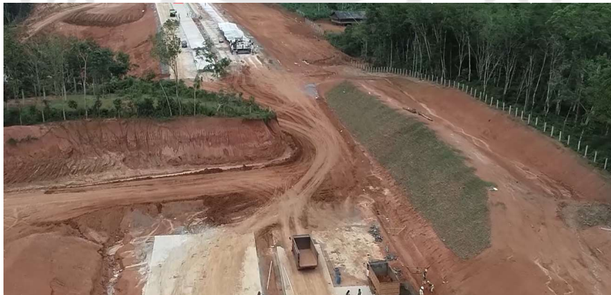
Gambar 46. Lokasi STA 3+800 – 4+000 Sisi Kiri
