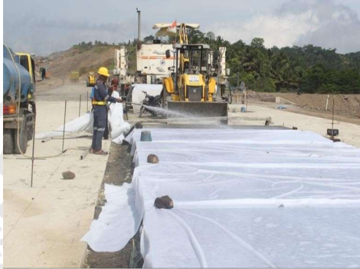
Gambar 36. Perawatan Beton dengan Penyiraman Air
