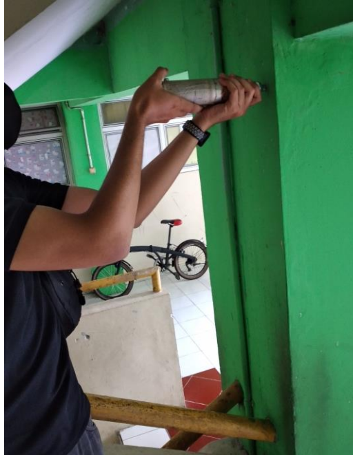
Gambar 5.10 Pengujian dengan Palu Beton
