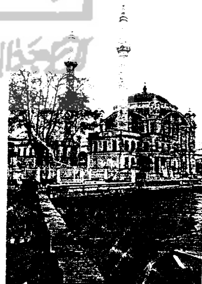
Gambar II.13 : salah satu bangunan monumen Sumber : Urban Design By cliff Mouglin
