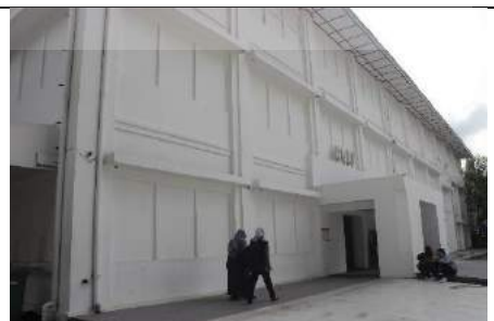
Gambar 3.13 gedung JNM (tanggal 8/12/18)
